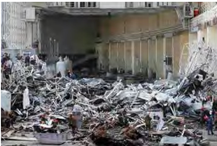
Figura 1: Daños en la central de Sayano-Shushenskaya
